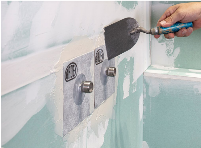
ARDEX SK-S Dehnzonenmanschette bei Rohrdurchführungen verkleben
