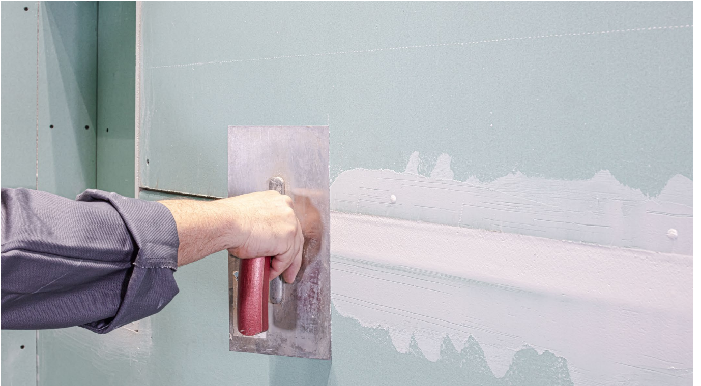
ARDEX R 1 Renovierungspachtel aufbringen
