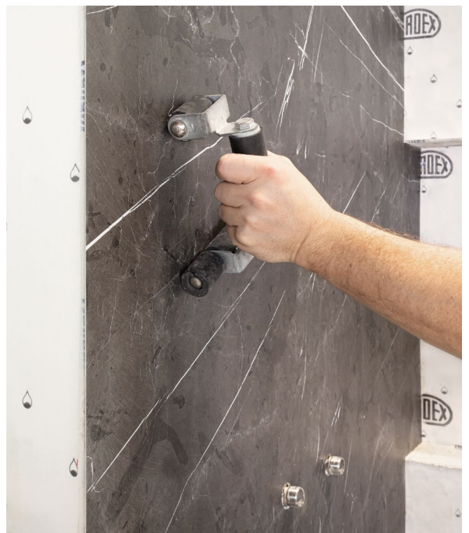
Gleichmäßiges und flächiges andrücken
