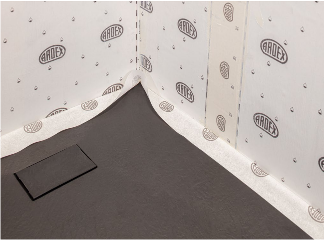
Duschtasse in Position bringen
