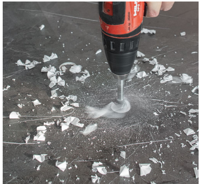
Aussparungen bohren bzw. schneiden
