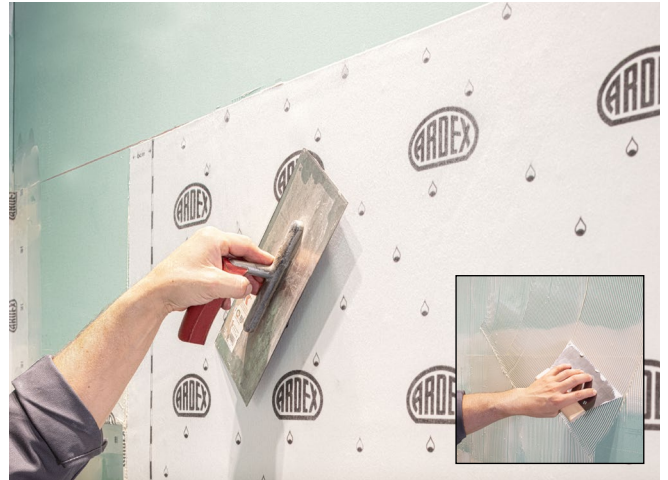
ARDEX SK 100 W TRICOM Dichtbahn verkleben
