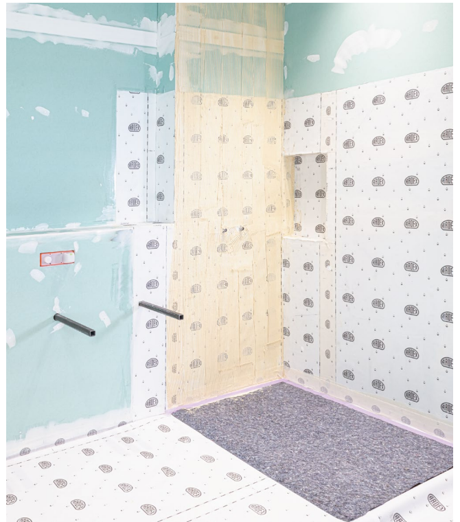
Der Klebstoff sollte kurz ablüften
