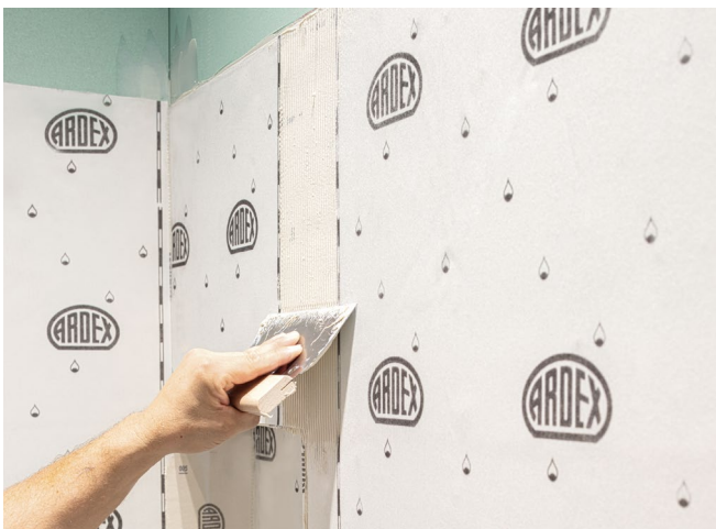
Kleber ARDEX AF 181 W im Stoßbereich aufbringen
