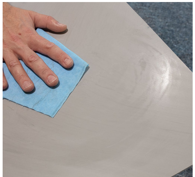
Plattenrückseite reinigen
