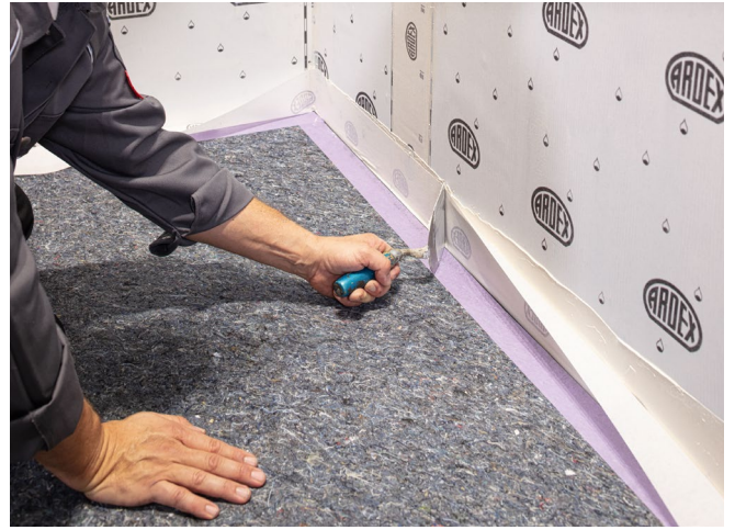
ARDEX SK 12 BT Wannendichtband an Wand verkleben
