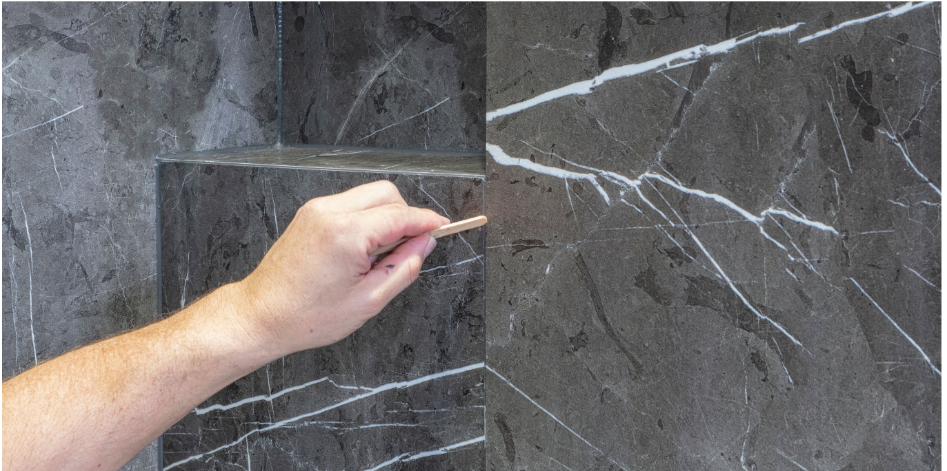
Abziehen des überschüssigen Silikons
