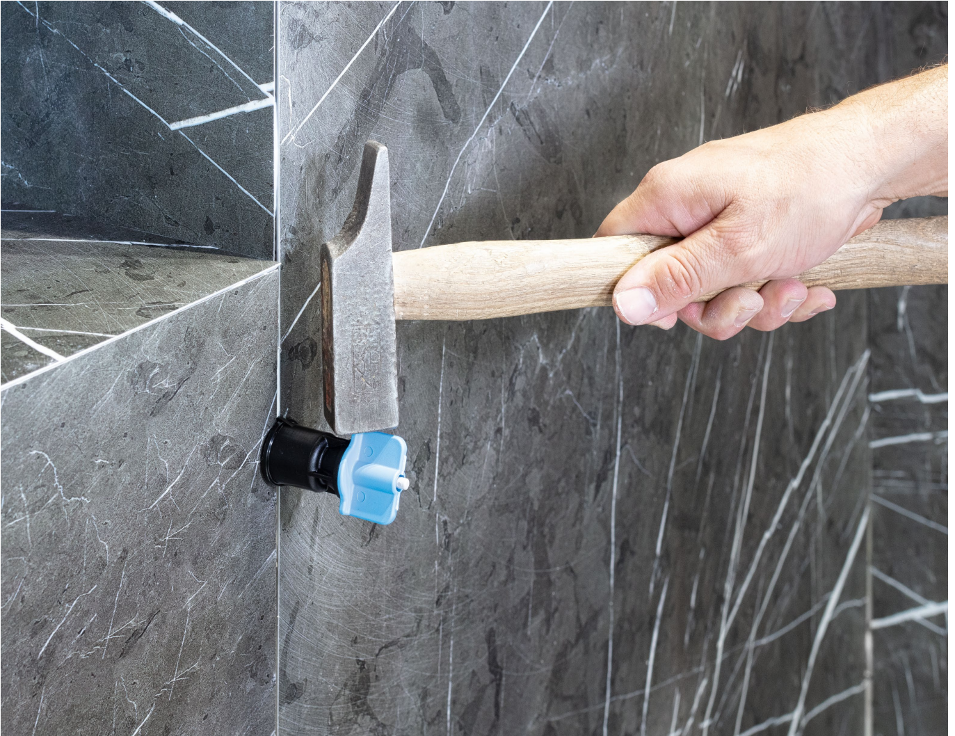
Zughaube mit Gewindelasche entfernen
