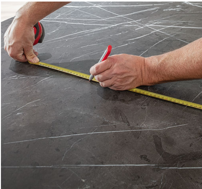
Zuschnittmaße auf Platten übertragen
