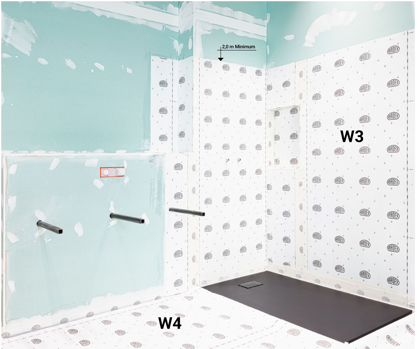
Vollständig ausgeführte Abdichtung: Duscbereich W3, Boden W4 Ausführung lt. Ö-Norm (siehe Seite 38)
